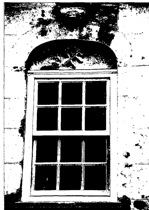
Timmermansgereedschap in het stucwerk boven een van de kozijnen in de voorgevel. Foto auteur.
