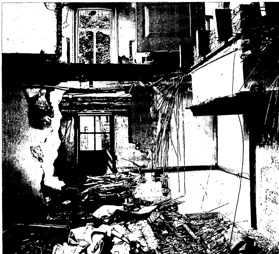
Het uit 1875 daterende Veldzicht, het enige landhuis te Doetinchem uit die tijd met een basement en belétage. Begin 1984 werden in het huis grote vernielingen aangericht. (zie foto B). Foto's: Henk Westerveld, Aalten
