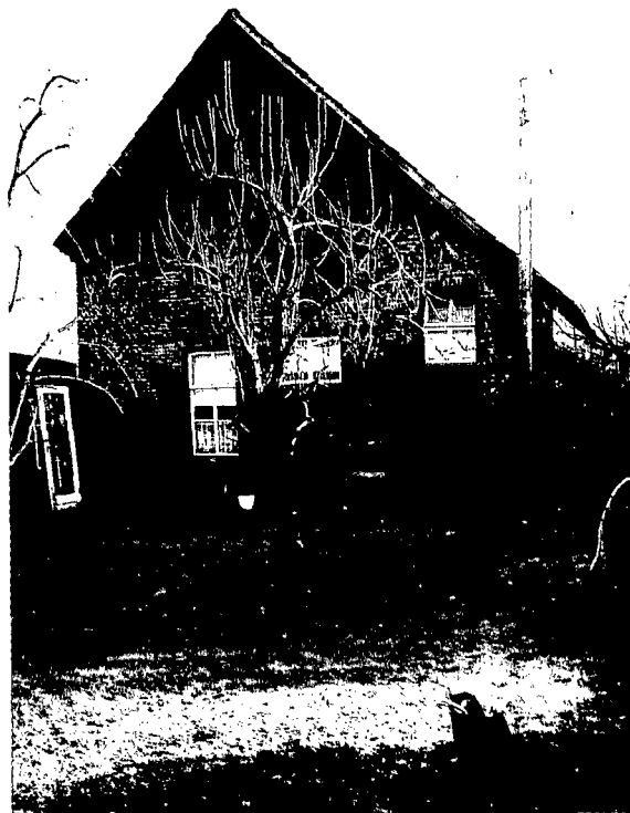
Afb. 2 Kopgevel van het hallenhuis waarin het jaartal 1719 voorkwam.
