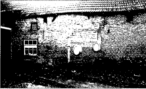
Afb. 3 De hoge gevel van het woongedeelte van het hallenhuis aan de noord-oostzijde. De bouwnaad ter plaatse van het overkragende zolderfront van de noord-westgevel is hierop zichtbaar.
