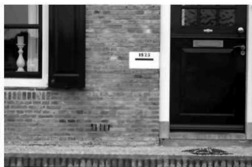
Peilmerk uit 1825 aan woning Havenkade 33 te Elburg
