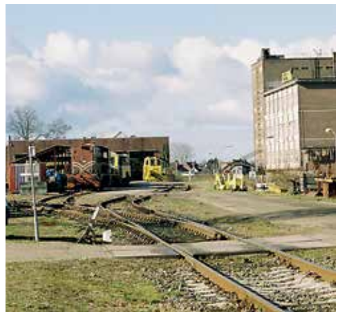
Afb. 2 Een foto uit 2008, met op de achtergrond de Strukton-werkplaats. Alle gebouwen op deze foto zijn inmiddels gesloopt. (foto: auteur)
