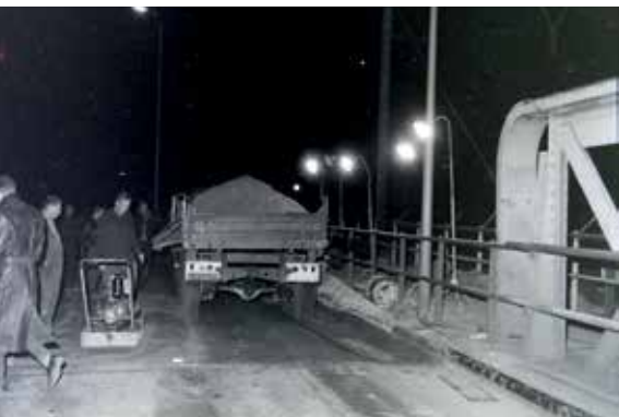
In het holst van de nacht werkt men aan de verbetering van de bocht in de oprit van de IJsselbrug in De Hoven. (Stedelijk Museum Zutphen, foto Zeylemaker)
