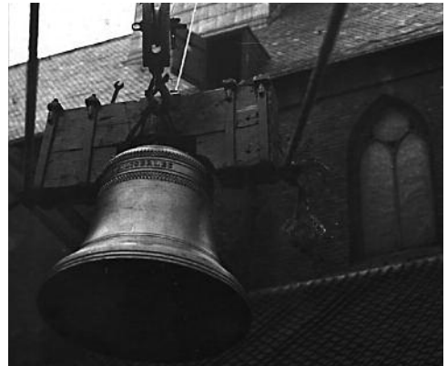
2 september 1948: het nieuwe poortklokje wordt naar zijn plaats van bestemming gehesen. (foto Zeylemaker, Stedelijk Museum Zutphen)
