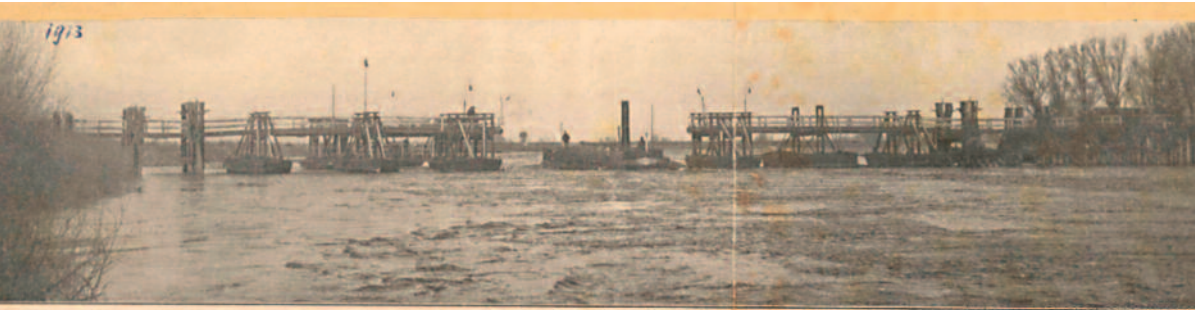
De IJsselbrug te Doesburg, genomen van af een kribbe; deze brug werd onlangs verlengd en is thans 110 M. lang; bovenstaande opname werd gedaan terwijl een sleepboot de opening door vaart.
