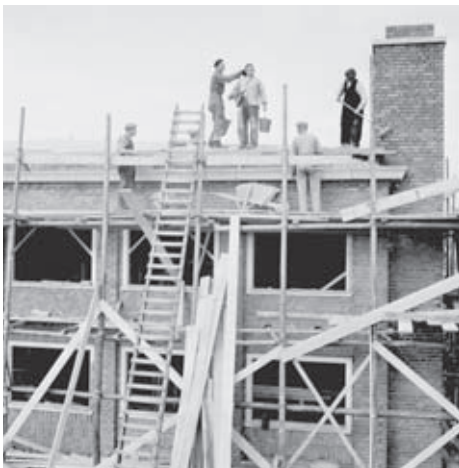
De nieuwe school aan de Isendoornstraat in aanbouw, 1950. (foto: W. van der Wielen)
