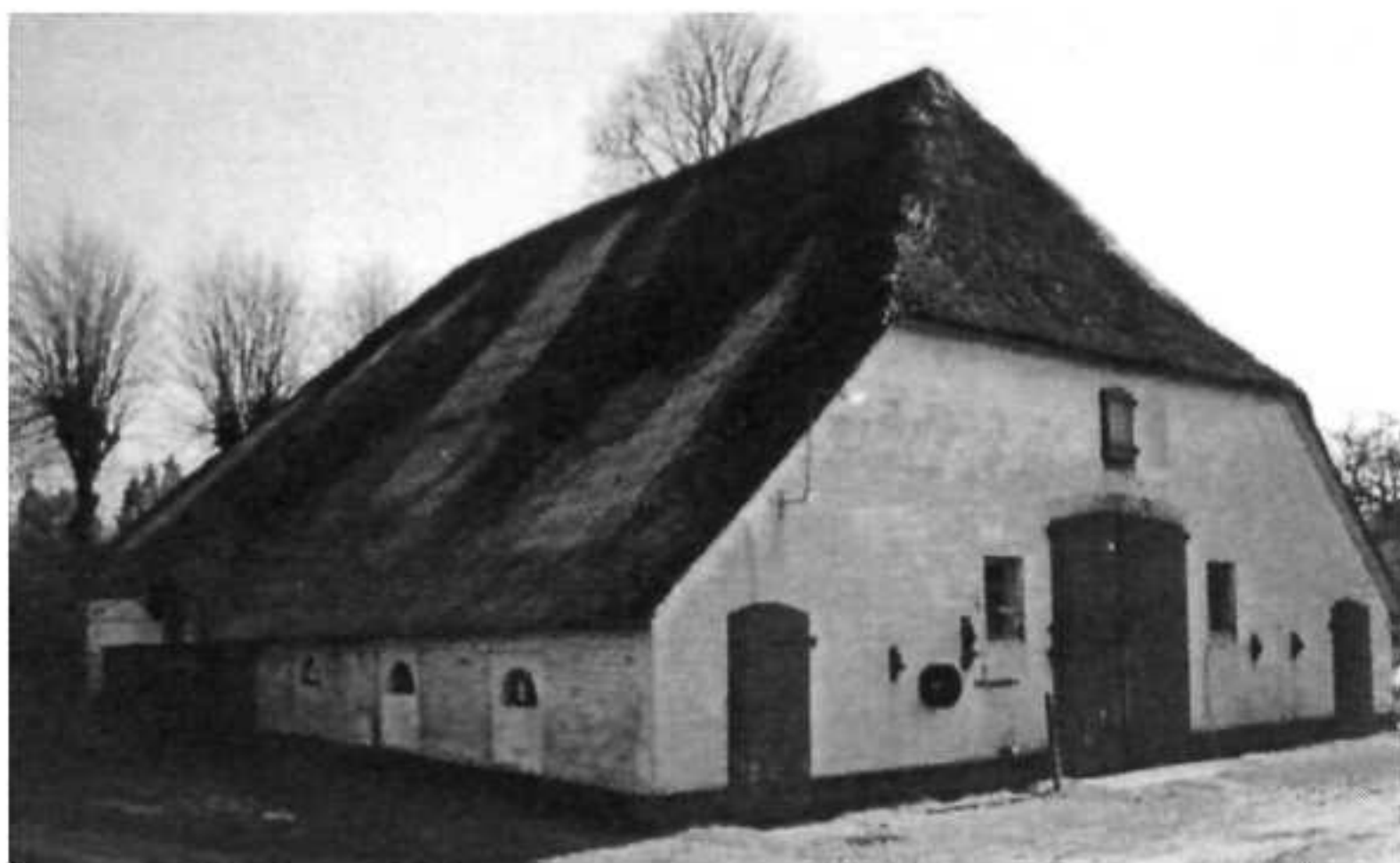
Linker zijgevel en achtergevel.
