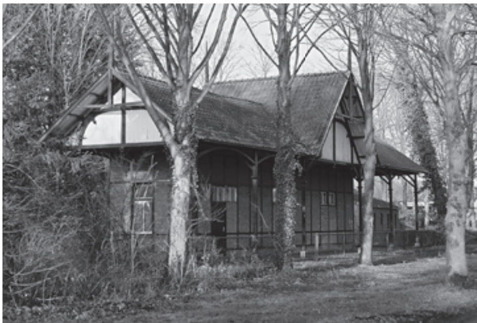
Het 'tranhuis' van Gorssel (Van de Capellenlaan) gefotografeerd in de richting Deventer (winter 2007/08). Aan deze kant (oostzijde) bevonden zich de tramsporen. Het is een gemeentelijk monument, een 'zeldzaam type stationsgebouw (ons geen vergelijkbare bekend) en bijzonder gaaf bewaard voorbeeld van de chaletstijl bij een gebouw van een tramwegmaatschappij'. (bron: Gemeente Lochem; foto: auteur)
