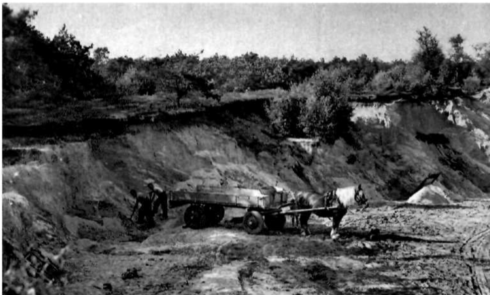
Nunspeet, zandafgraving achter het tolhuis t.b.v. het te bouwen zwembad.
