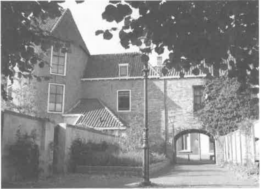
Oskamstraatje: ondiepe huizen gebouwd tegen de stadsmuur.
