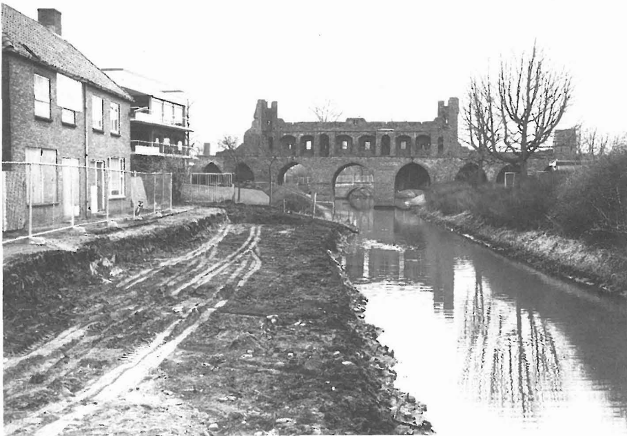
De huizen links staan aan de Beekstraat, op het kale stuk zijn nieuwe woningen gebouwd. De flat van Huize St. Elizabeth is intussen verdwenen. (Foto: Collectie Wijnhuisfonds)
