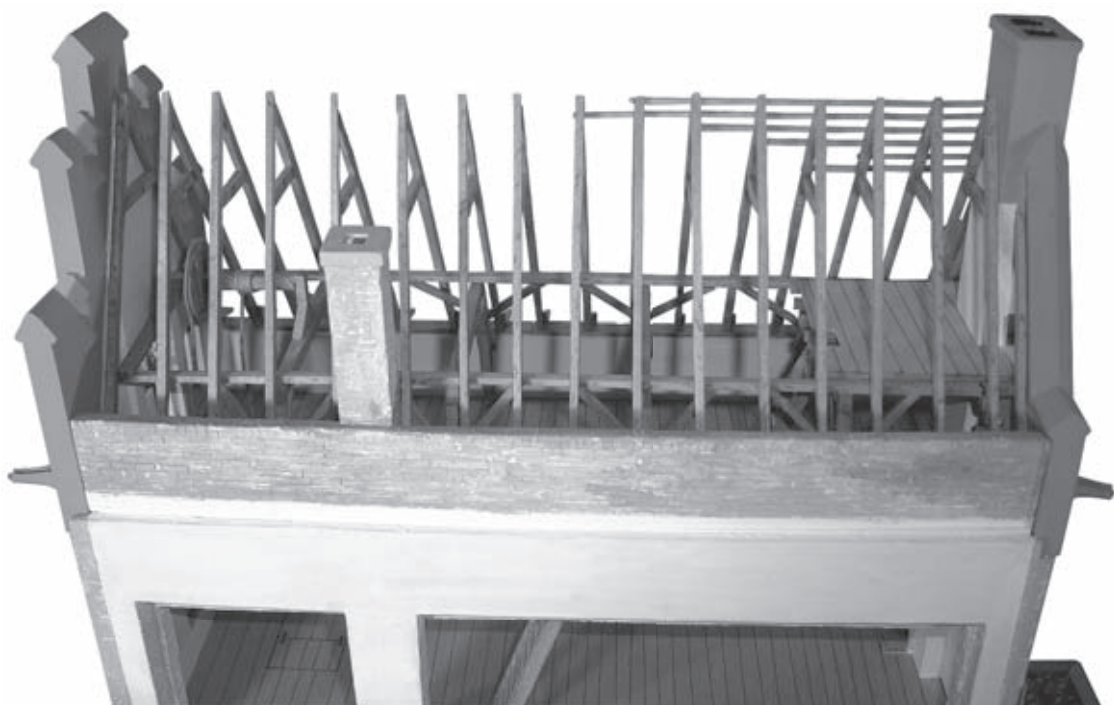
Overzicht van de zolder met uiterst links het hijswiel; op de voorgrond de hoger dan de achterliggende goot opgetrokken brandmuur.
