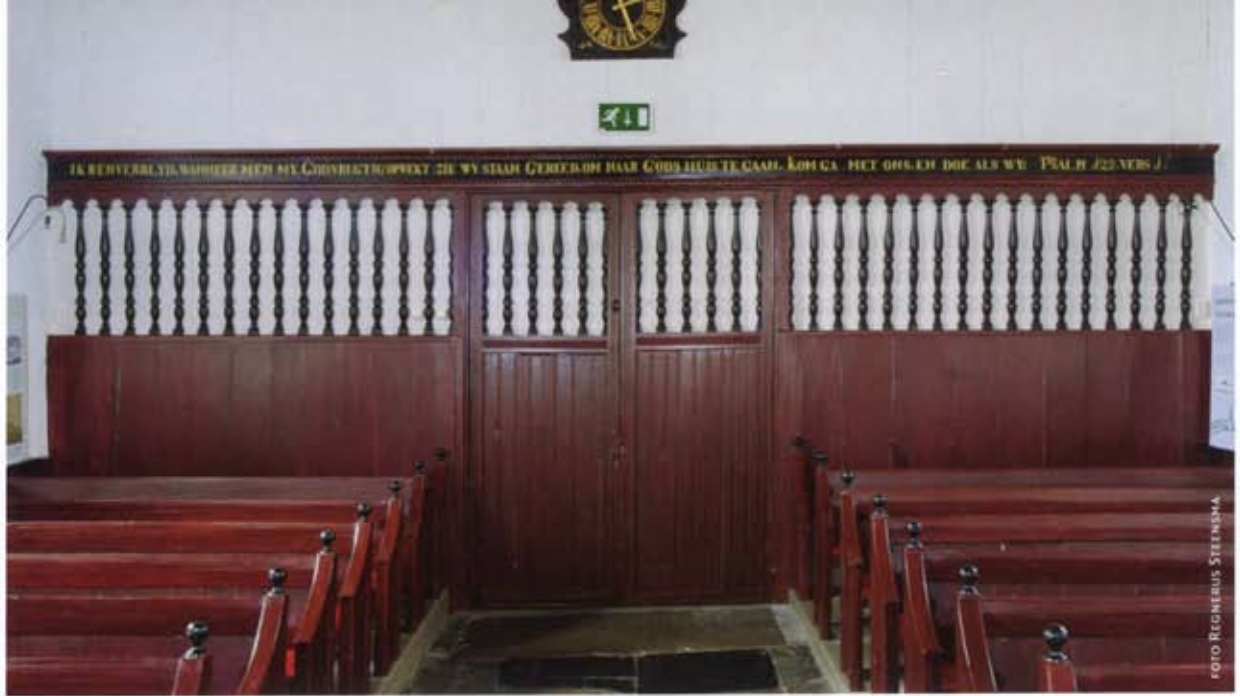
3 Niehove, afsluiting tegen de westwand, mogelijk voorheen een koorhek
