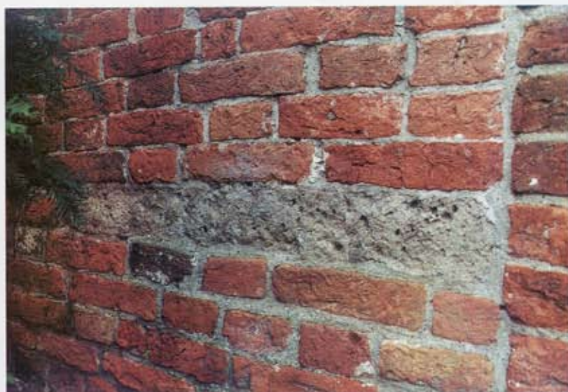
3. De 'steen' in de zuidgevel van de kerk van Baflo bestaat in werkelijkheid uit drie stenen.
