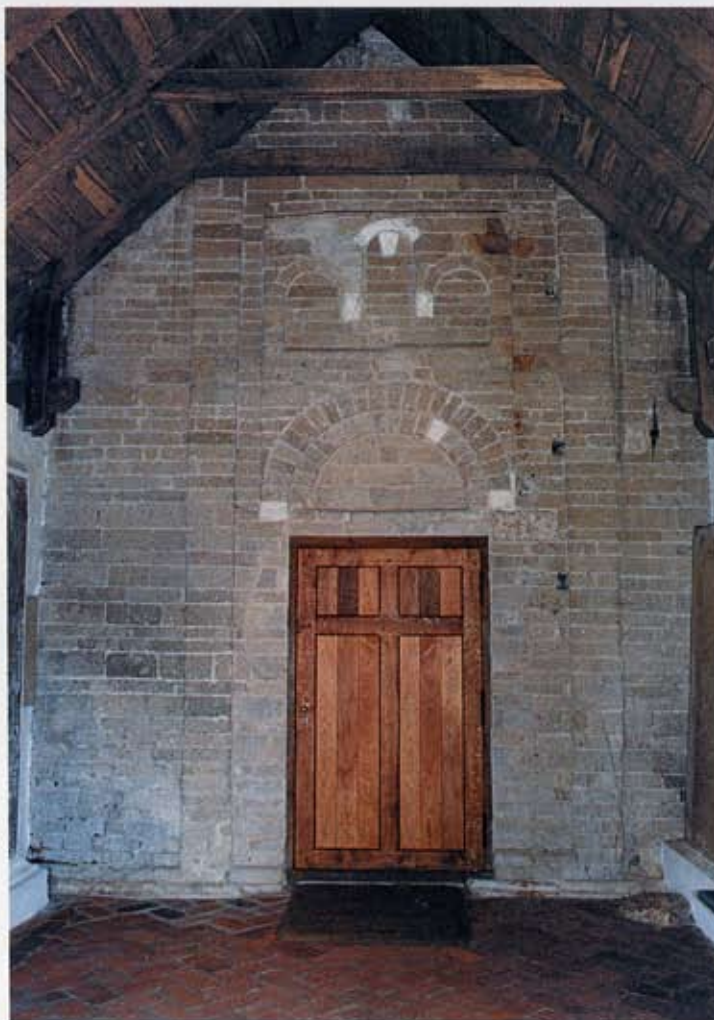
2. Een deel van de tufstenen noordmuur van de kerk van Vilslev, West-Jutland, dat tot de drie eeuwen later volgende aanbouw van een vābenhus, en sindsdien, ongepleisterd is gebleven.
