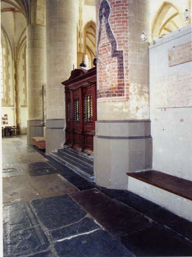
9 Martinerkerk, de noordzijde van de kooromgang naar het oosten. De zwarte omlijsting rond de nis geeft de plaats van een beeld aan en zeer waarschijnlijk stond hier een altaar
