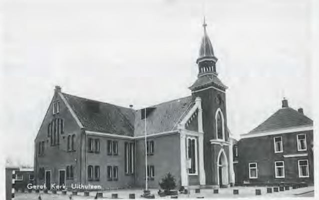
4 De kerk in Uithuizen uit 1866 met het in 1892 gebouwd dwarschip.
