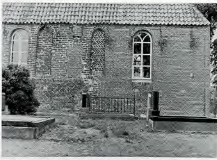
3. Oostelijk deel van zuidgevel na restauratie.
