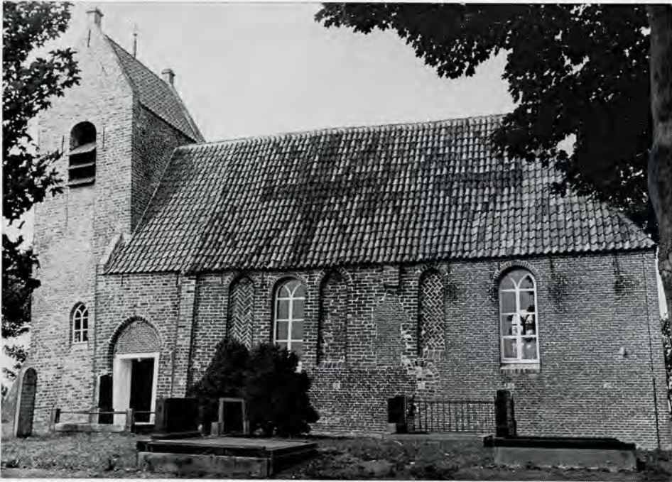
5. Zuidgevel na restauratie.
