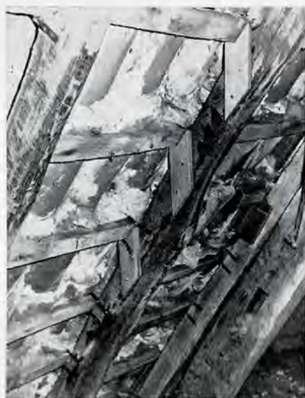
1. Visbek-draagkonstruktie van de panlatten.
