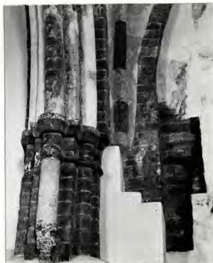
Rechts op de foto de inkassing in de muur, die de gordelboog met natuurstenen kapiteel van het afgebroken transept laat zien.
