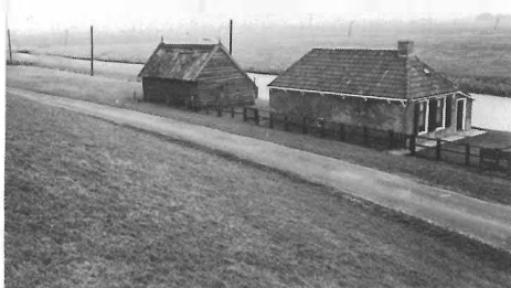
DIKWEG SCHUUR MET WRAKHOUT OP DAK
