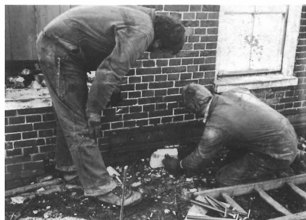
Onder aan de gevel werd aan beide zijden een ijzeren balk geplaatst, waartussen het gevelfragment met grote bouten werd geklemd, 1973.
