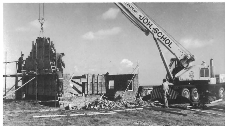
De ingepakte voorgevel werd per vrachtauto naar Enkhuizen vervoerd, waar eerst het onderstuk op het fundament werd geplaatst, 1970. Vervolgens werd met een kraan de topgevel geplaatst en verankerd, 1970.
