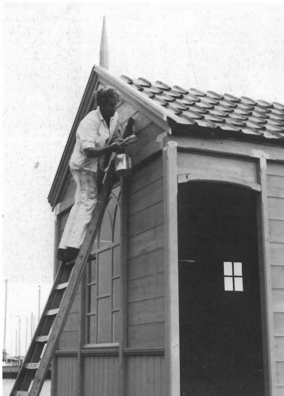
Het metselen van de vlechtingen in de voorgevel van het pandje uit Moddergat, 1973.
