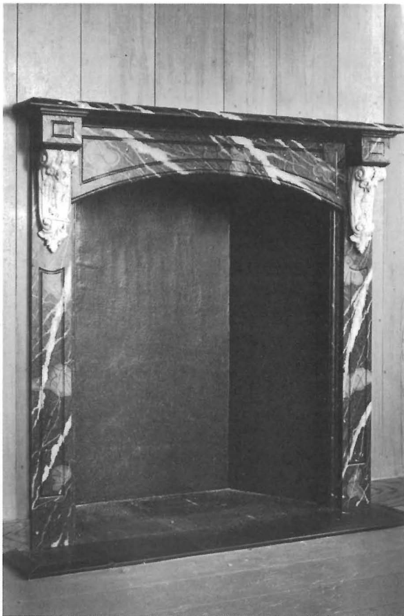
Op basis van aangetroffen bouwsporen werd een andere schoorsteenmantel aangebracht (foto links), die in overeenstemming is met de periode waarin het interieur ingericht zal worden, 1983.
