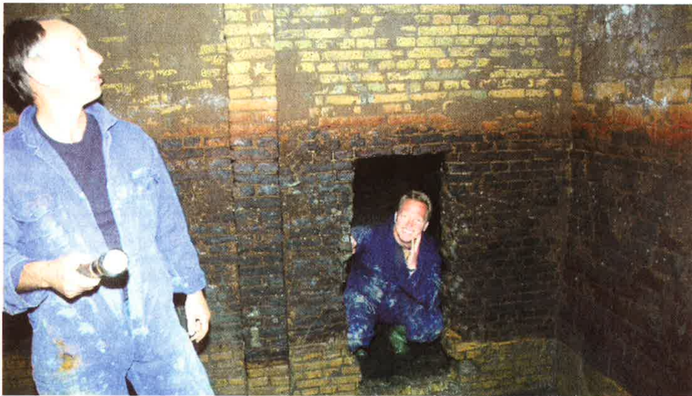
Medewerkers Gerrie Muizelaar (links) en Jack Vriend van het Zuiderzeemuseum bekijken een van de ondergrondse kelders onder de tuin van het Binnenmuseum aan de Wierdijk.
