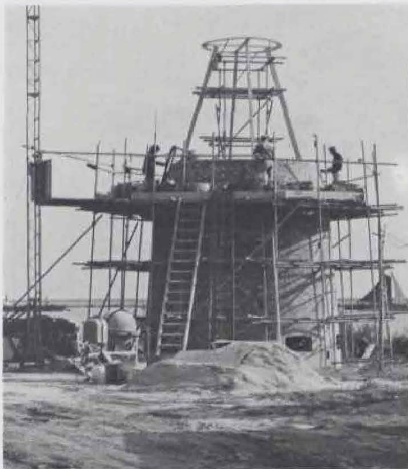
Een van de kalkovens van Akersloot in herbouw op het Buitenmuseum.
