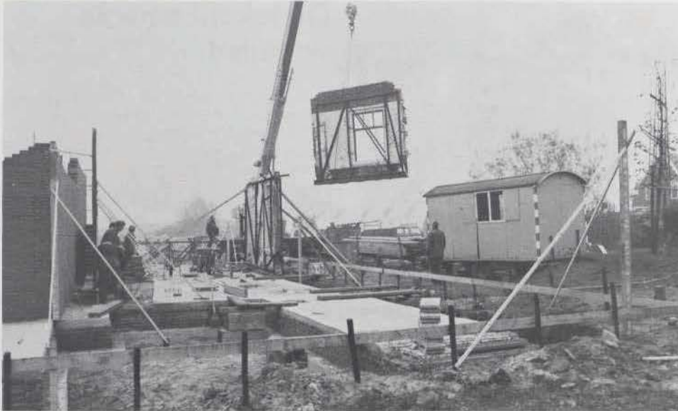
Opbouw van de panden van Hoorn. Gedeelte van wanden worden op de fundering geplaatst.
