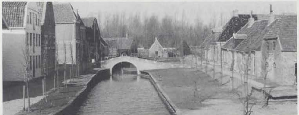
Boven: De dijk langs de werkhaven is op hoogte gebracht.
