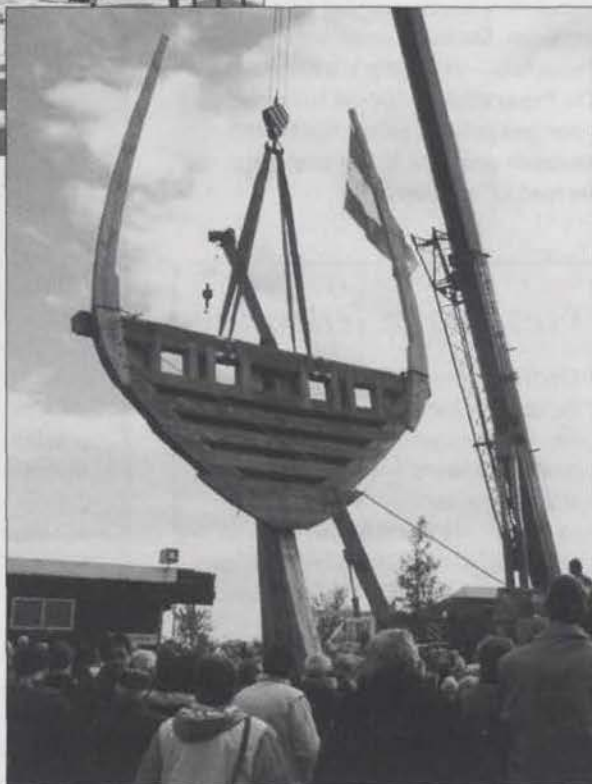
Plaatsing van de spiegel voor de Zeven Provinciën op 3 november 1995 onder grote publieke belangstelling.
