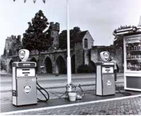
De gewraakte benzinepomp op het Hagepoortplein. (Stedelijk Museum Zutphen)
